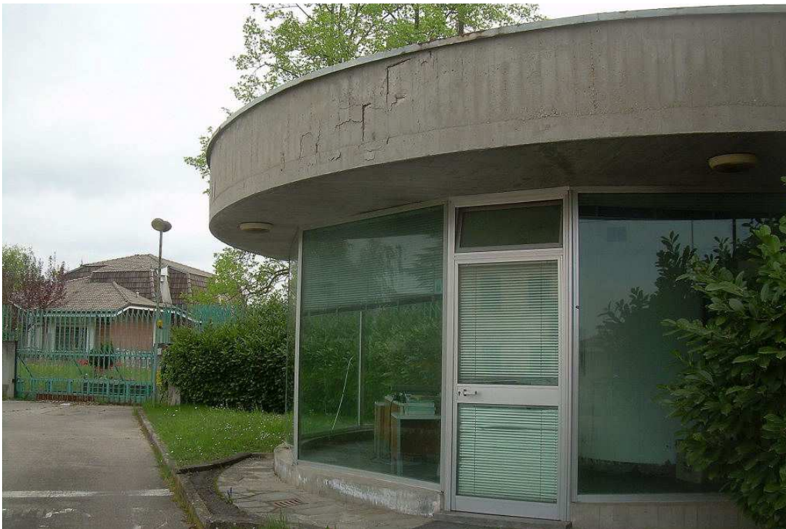
L'edificio ospitante la guardiana localizzato in prossimità degli accessi carrai (fabbricato a7 della Figura 3.1.2/I)
