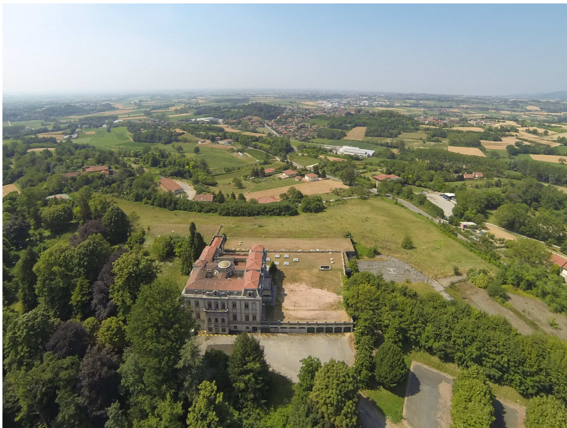
Vista aerea del complesso di Villa Monplaisir
