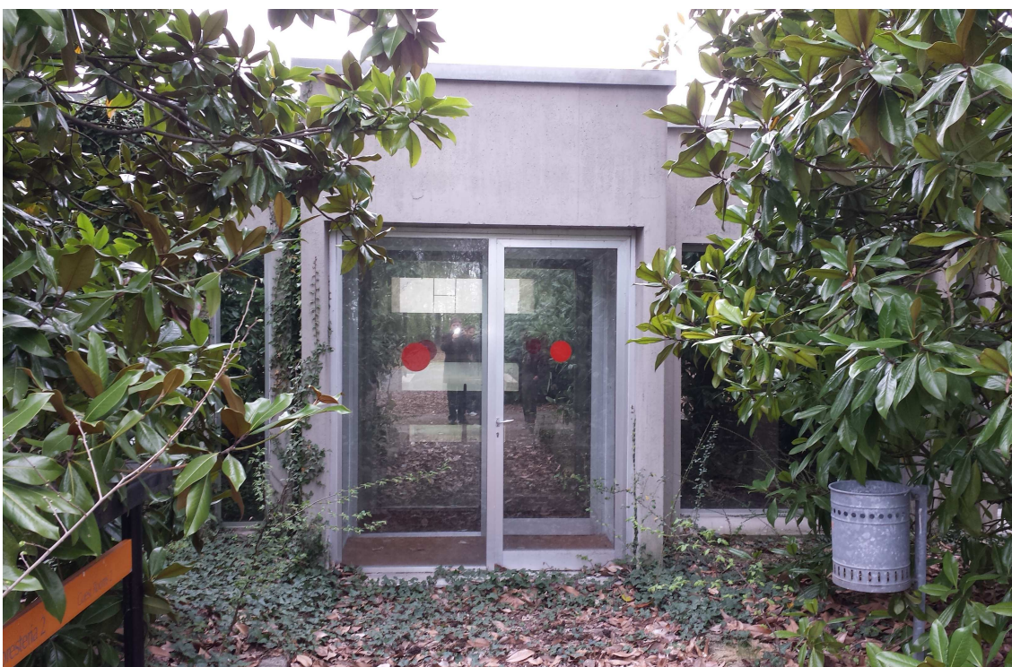
Ingresso alla foresteria semi-ipogea che si affaccia sul versante est della collina (fabbricato a5 della Figura 3.1.2/I)
