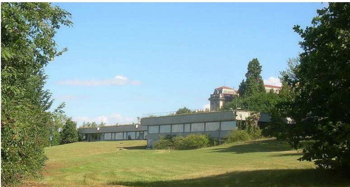
Vista dei corpi di fabbrica semi-ipogei localizzati sul fianco sud-ovest della villa (edifici a2 e a3 della Figura 3.1.2/I)
